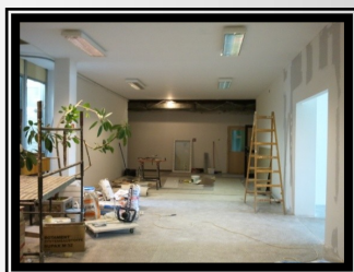
Instytut Historii w trakcie remontu
