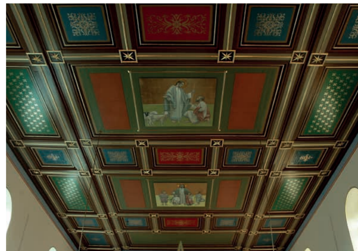
Wnętrze kościoła po konserwacji
