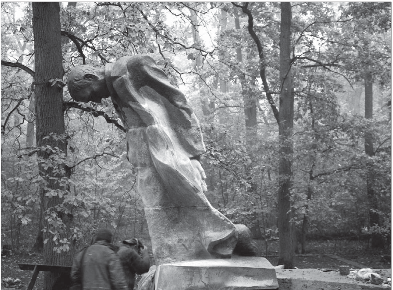
Pomnik w Barbarce w trakcie montażu (fot. Zbigniew Walewski)
