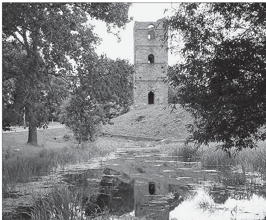
Wieża w Stołpiu, widok współczesny (fot. Andrzej Buko)
