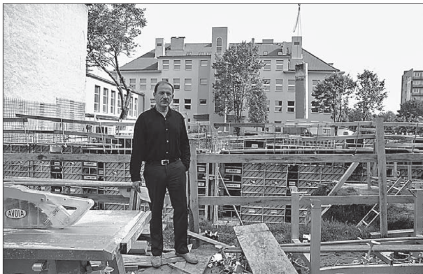
Prorektor UO prof. Stefan M. Grochalski na budowie Studenckiego Centrum Kultury
