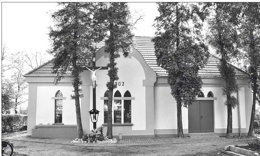
Kaplica – półtora roku po pożarze
