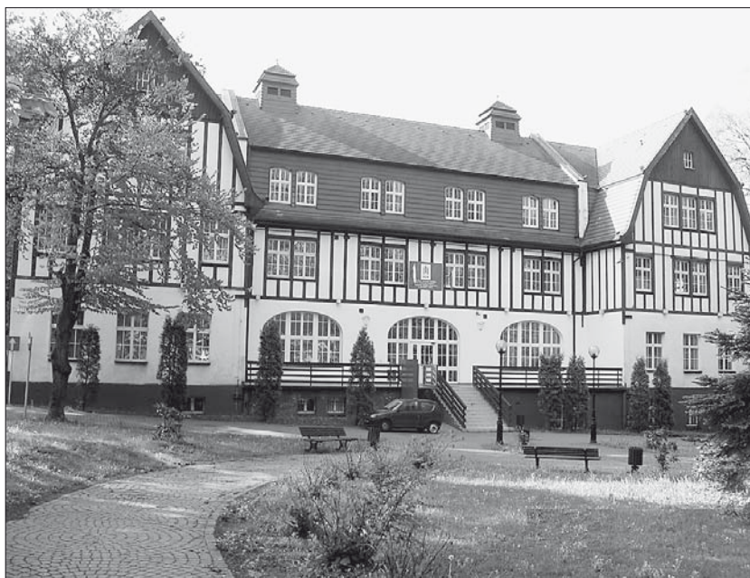
Budynek Zamiejscowego Ośrodka Dydaktycznego UO w Jastrzębiu Zdroju
