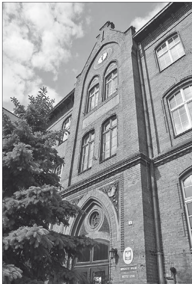
Rozpoczął się remont kapitalny zabytkowego obiektu Instytutu Sztuki (fot. Tadeusz Parcej)
