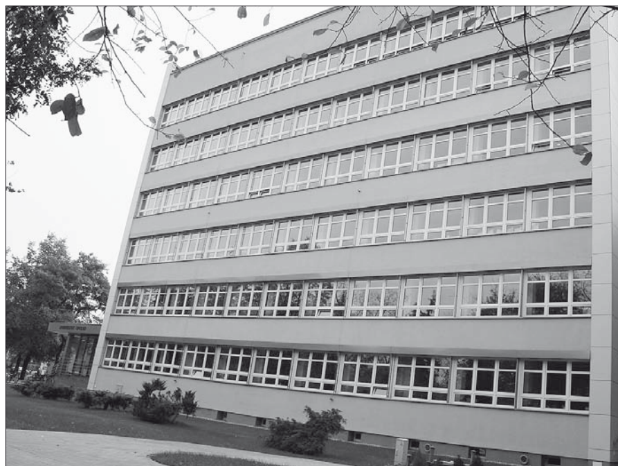
Obiekt Wydziału Chemii – po remoncie
