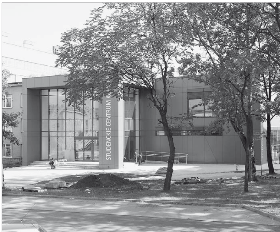
Ostatnie prace na budowie Studenckiego Centrum Kultury (wrzesień br.)
