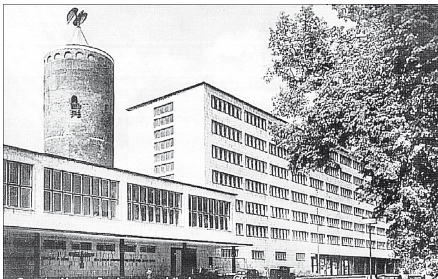
Nowy gmach rejencji opolskiej (w tle Wieża Piastowska z nowym hełmem), ok. 1936 r.
