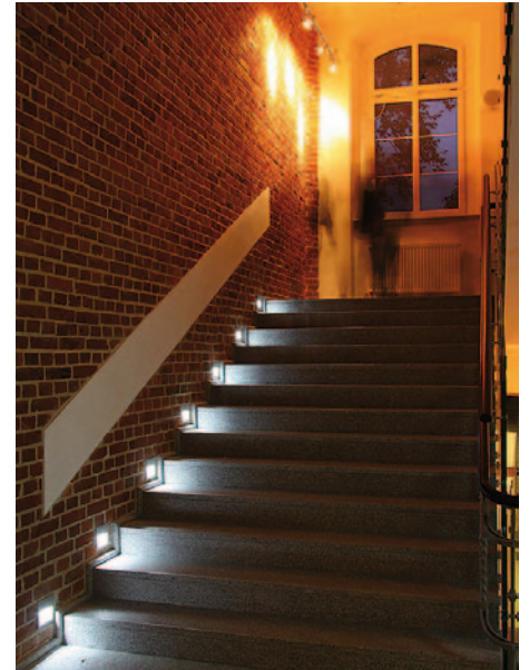
Stara, ceglana ściana przy schodach prowadzących na piętro
