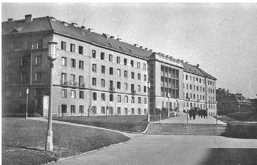
Akademik „Mrowisko” od strony uczelni, po wykonaniu asfaltowych dojazdów do wszystkich budynków WSP (marzec 1963)
