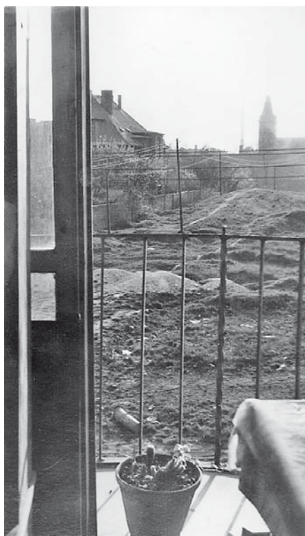
Widok z balkonu pierwszego piętra DS „Mrowisko” na kościół Jezuitów w roku 1958
