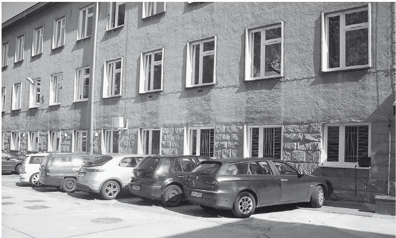
Okna pomieszczeń zajmowanych przez warsztaty Instytutu Fizyki
