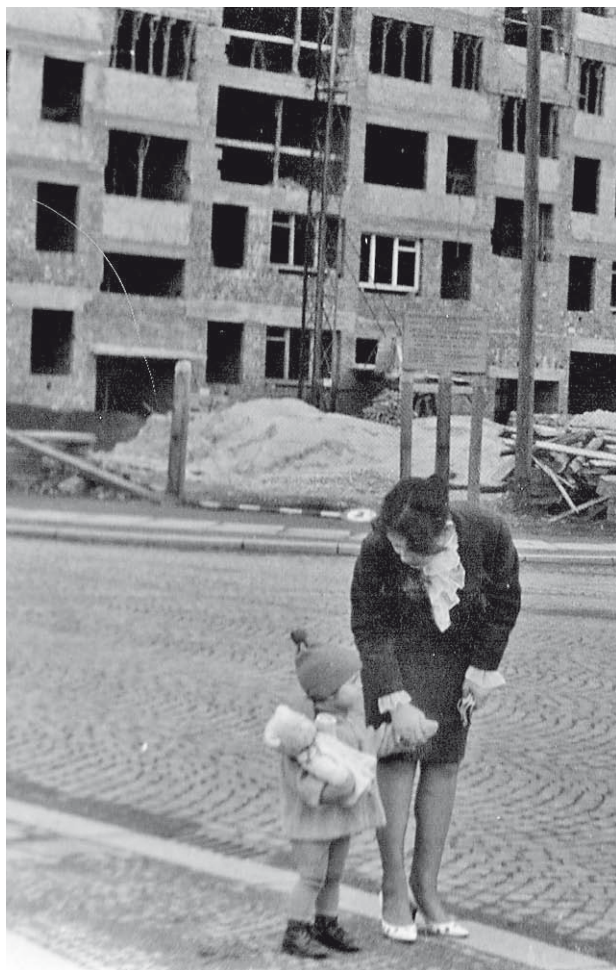
Trwa budowa Domu Profesora przy ulicy Oleskiej 45 (wiosna 1965 r.)
