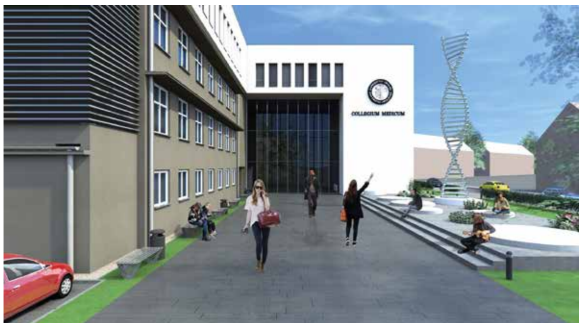
Tak będzie wyglądać budynek wznoszonego Collegium Medicum UO, w którym już w październiku br. rozpoczną naukę pierwsi studenci kierunku lekarskiego
