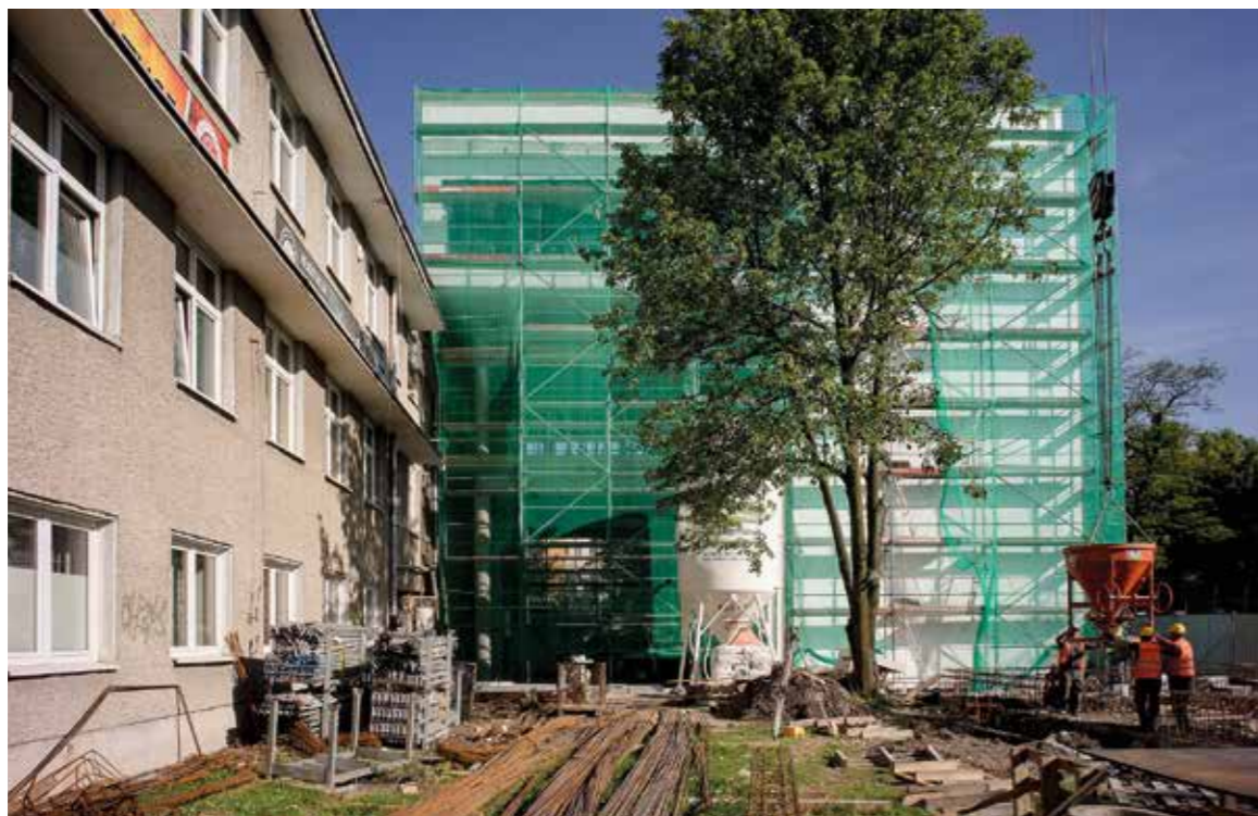
Prace budowlane trwają (koniec maja br.). Fot. Sylwester Koral
