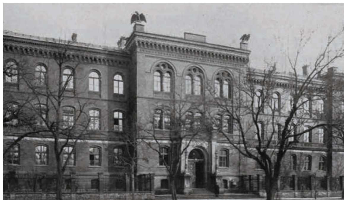
Nieistniejący budynek sądu. Dziś w jego miejscu stoi dom mieszkalny przy ul. Książąt Opolskich 48-50 (fotografia Maxa Glauera, w: A. Neugebauer, Die Stadt Oppeln... )
