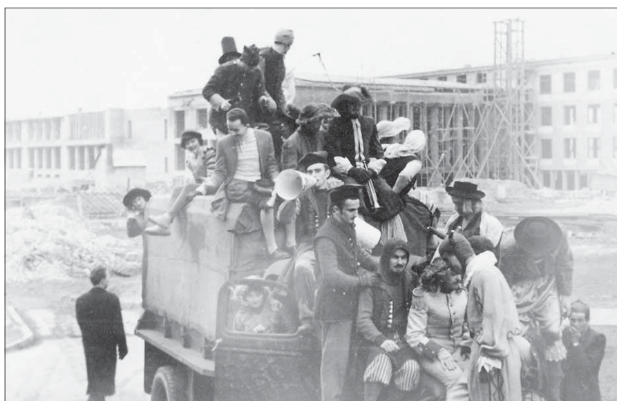
Studenci polonistyki na placu budowy. Styczeń 1959 r.
