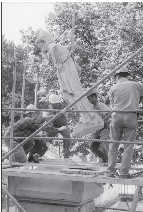
W trakcie montażu na mostku nad fosą.
