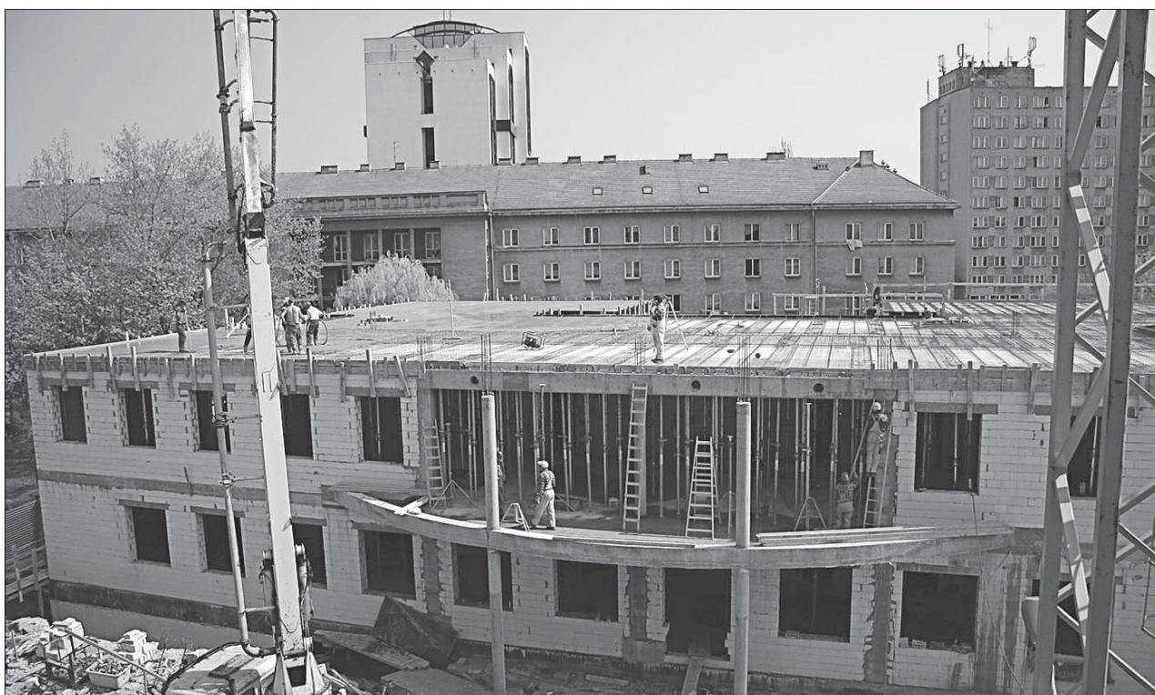
Rosną mury przyszłej siedziby Wydziału Nauk Społecznych UO. Koniec kwietnia 2006 r.
