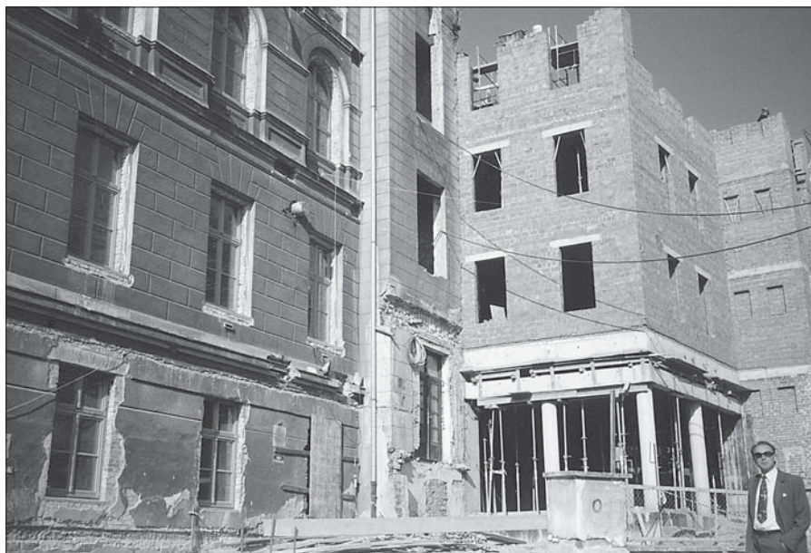
Stare i nowe – wejście główne budowano od podstaw
