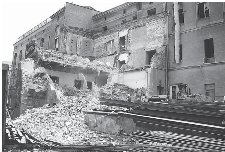
W wielu miejscach remont zaczynał się od wyburzenia starych ścian
