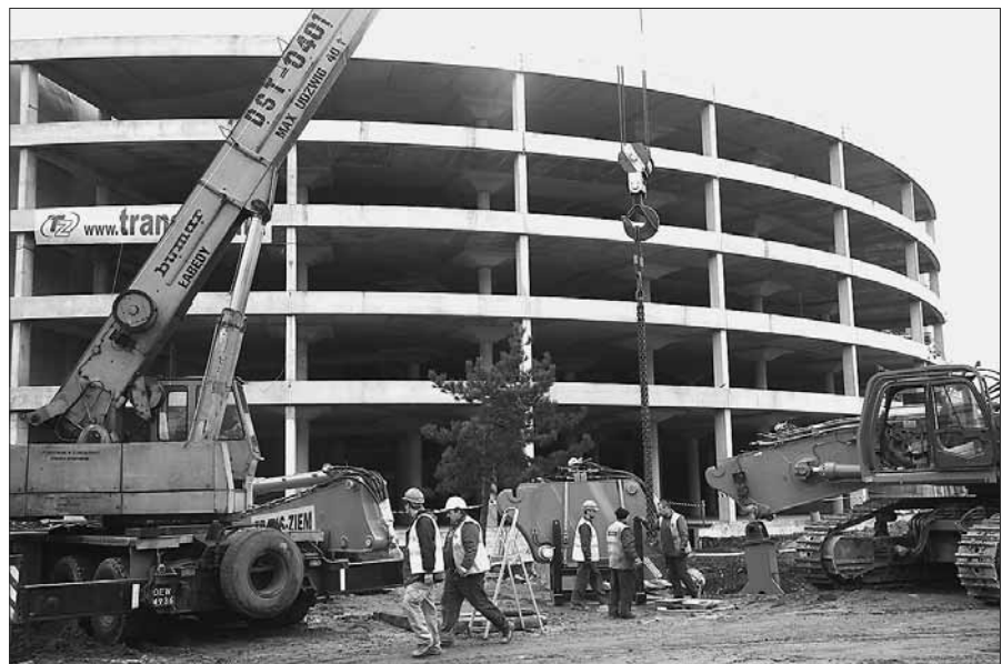
Plac Kopernika w 2007 r. Rozpoczęto rozbiórkę niedoszłego „Copernicus Center”.
