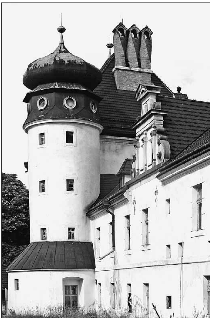
Fragment skrzydła północno-zachodniego zamku w Dąbrowie z widocznymi, stylowymi, skręconymi kominami. Fot. J. Stemplewski
